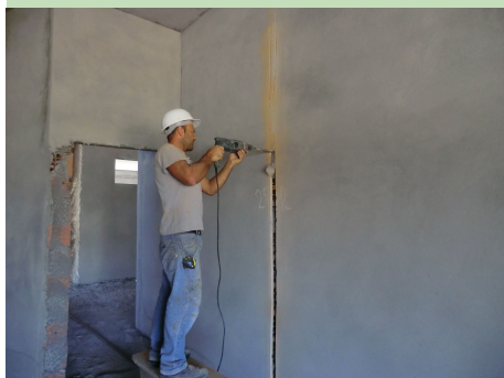
Para garantir entrega no prazo, obra continua.
