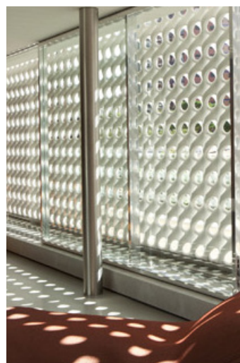
Figura 12 - Utilização de cobogós para melhorar a iluminação e ventilação natural. Projeto de Márcio Kogan.
